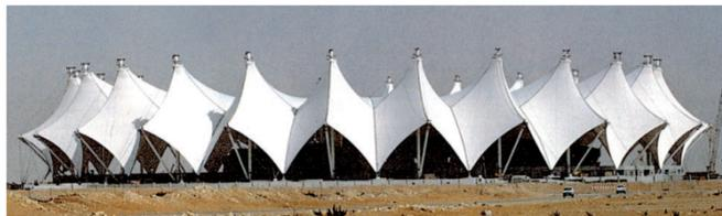
Para abaratar los costes de apoyo y anclaje en las estructuras tensadas se aprovecha el perímetro del edificio para anclar los cables, como sucede en el estadio en Riad, o en las torres de refrigeración en Schmehausen.
