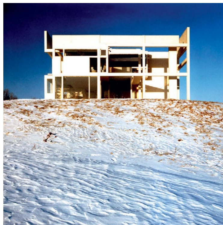
Casa II, Hardwick, Vermont, EE.UU. (1969-1970)
